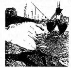
Polyfelt TS spart Zeit, Kosten und Schüttmaterial und hilft besser, billiger und schneller zu bauen. Polyfelt TS – Trenn- und Filterschicht zwischen schlammigem Boden und Kiesdrainage oder Schüttung, im Straßenbau, im Bahnbau, im Wasserbau, bei der Anlage von Sportplätzen, Lagerplätzen oder Grünflächen auf Dachterrassen.
