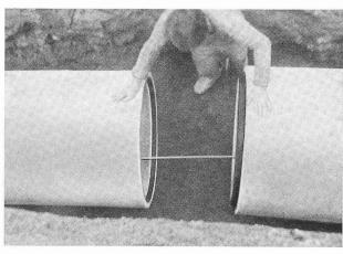
Mise en place simplifiée de tuyaux en béton livrés avec bandes « BFL-Mastix » incorporées aux embouts mâle et femelle des emboîtements.
