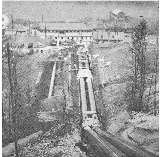
Fig. 14. — Enrobage des conduites forcées.
