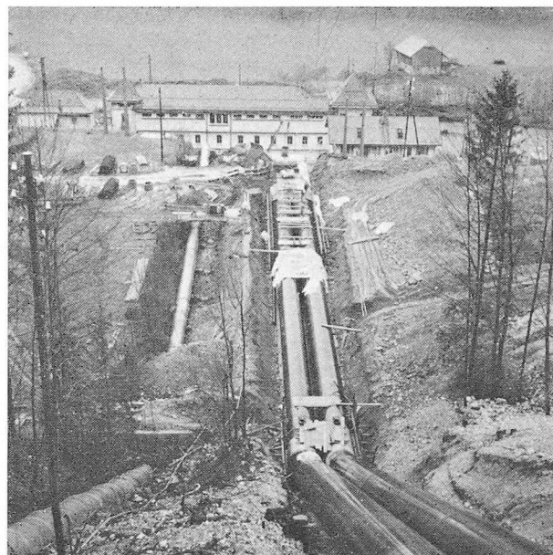
Fig. 14. — Enrobage des conduites forcées.
