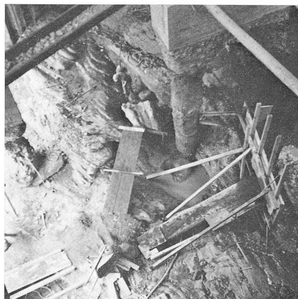
Fig. 5. — Dégagement d'un pieu coulé dans le sol.
