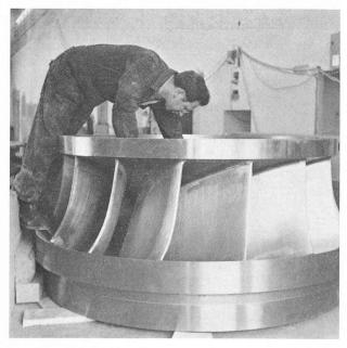
Fig. 13. — Roue de la turbine.
