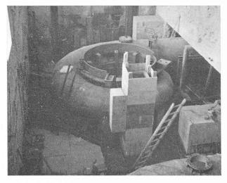
Fig. 10. — Montage d'une bâche spirale.
