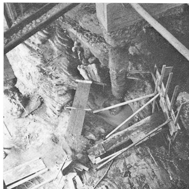
Fig. 5. — Dégagement d'un pieu coulé dans le sol.
