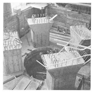
Fig. 11. — Piliers supportant l'alternateur.
