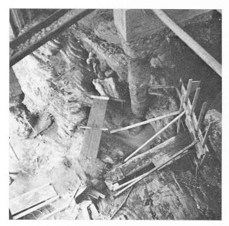
Fig. 5. — Dégagement d'un pieu coulé dans le sol.
