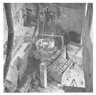
Fig. 9. — Montage d'un coude d'aspirateur.
