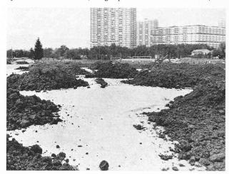
Mise en place de la terre végétale sur les nappes de Bidim, le sol étant préalablement nivelé et recouvert de grave.
