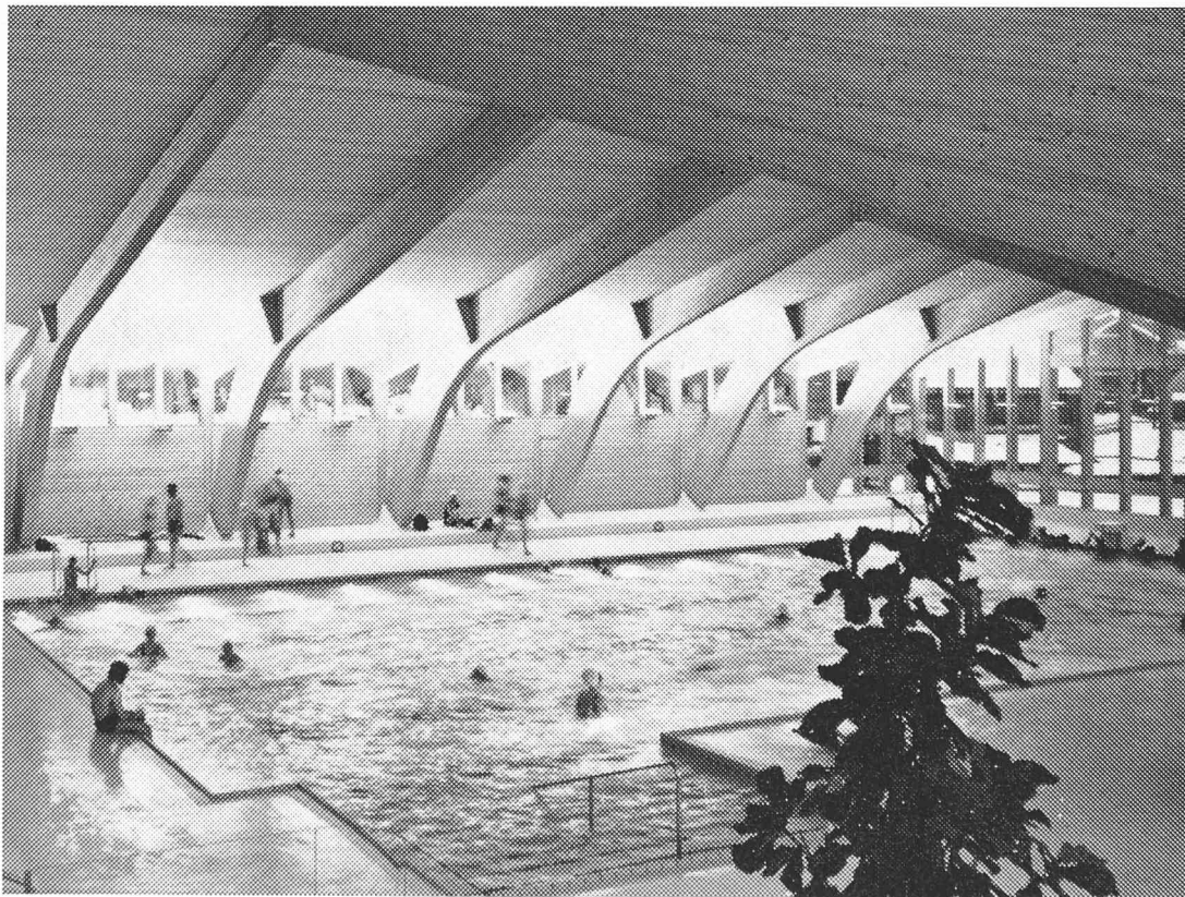
Les piscines dans lesquelles le baigneur recherche le repos et la détente doivent être confortables. On parvient à remplir cette condition en employant le bois, matériau qui répond également aux exigences de la physique du bâtiment. Le rayonnement naturel du bois est un stimulant qui prédispose au mouvement et à l'activité sportive (photo Fäh, Gstaad).
