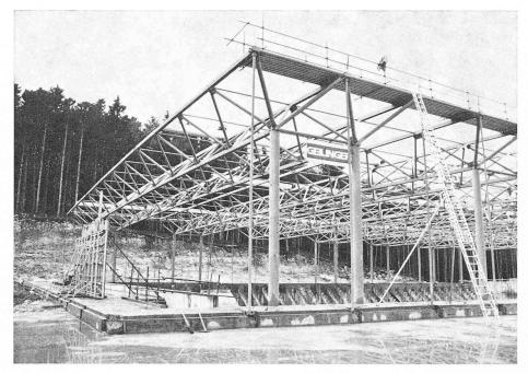
Fig. 4. — La structure en cours de montage.
