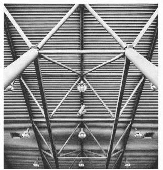
Fig. 5. — Détail d'une poutre en treillis spatial.
