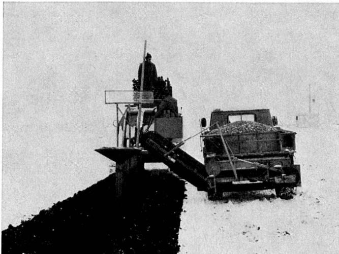
Pose de tuyaux en barres de 5 m et introduction du gravier d'assainissement d'un seul passage.
