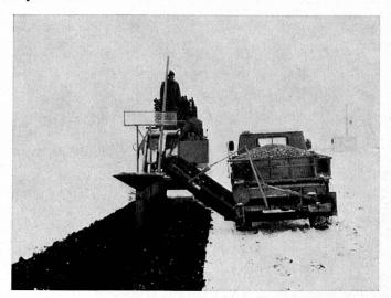
Pose de tuyaux en barres de 5 m et introduction du gravier d'assainissement d'un seul passage.
