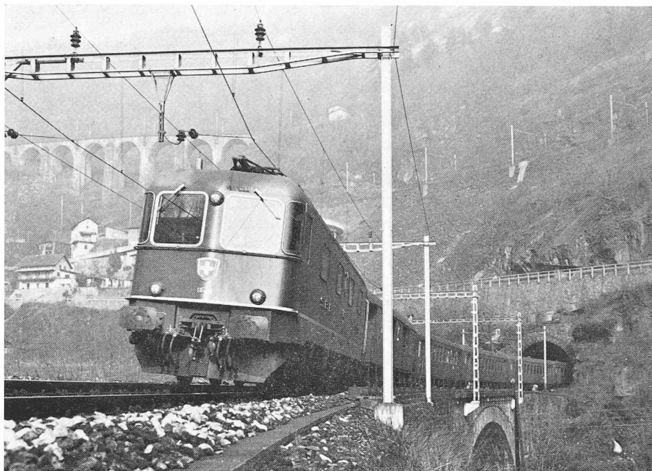
Locomotive Re 6/6 en tête d'un train du Gothard (photo BBC).
