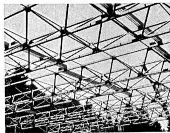
Les ossatures en acier sont légères et aérees: La salle omnisports géante de Macolin, dont les poutres triangulées couvrent la surface de jeu d'une portée de 50 m en supportant jusqu'à 300 kg/m<sup>2</sup> de neige.
