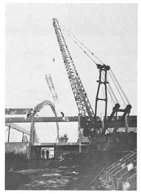
Fig. 7. — Montage d'un arc assemblé, au moyen d'une grue de 100 t.
