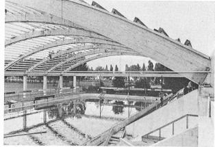
Fig. 4. — Vue de la charpente, avec appuis sur les tribunes existantes, côté sud-est.
