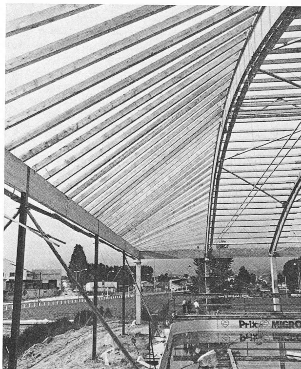
Fig. 6. — Poutre de pignon et charpente d'extrémité.
