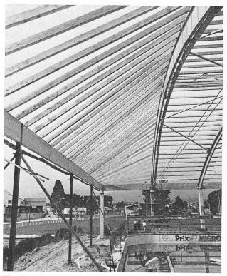
Fig. 6. — Poutre de pignon et charpente d'extrémité.
