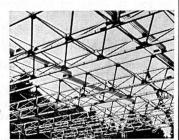
Les ossatures en acier sont légères et aérées: La salle omni-sports géante de Macolin, dont les poutres triangulées couvrent la surface de jeu d'une portée de 50 m en supportant jusqu'à 300 kg/m² de neige
