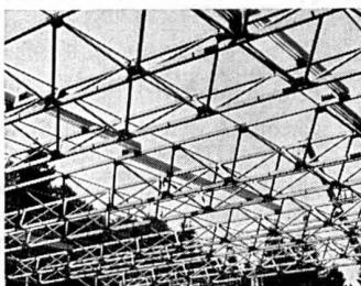
Les ossatures en acier sont légères et aérées. La salle omnisports géante de Macolin, dont les poutres triangulées couvrent la surface de jeu d'une portée de 50 m en supportant jusqu'à 300 kg/m<sup>2</sup> de neige.
