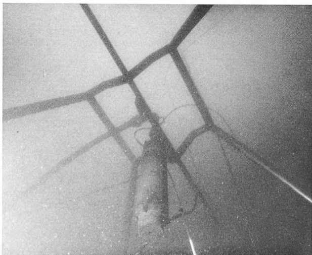
Fig. 1. — Vue sous-marine de la pompe immergée et du châssis
