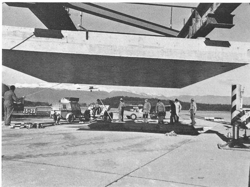
Fig. 3. — Mise en place de la dalle préfabriquée pesant 45 tonnes.
