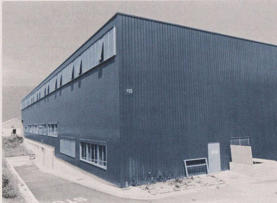
Revêtements de façade et supports de toiture en acier nervuré ACIÉROÏD de halles au CERN (Centre européen de recherche nucléaire) près de Genève — plus de 35 000 m<sup>2</sup>.
