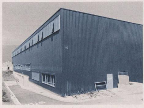
Revêtements de façade et supports de toiture en acier nervuré ACIÉROÏD de halles au CERN (Centre européen de recherche nucléaire) près de Genève plus de 35 000 m².
