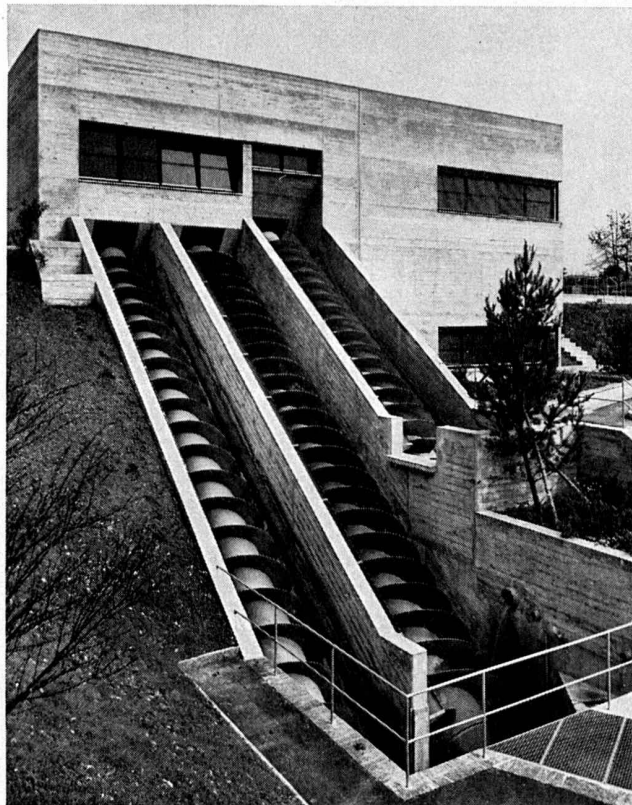
Station d'élévation pour eaux usées avec vis d'Archimède dans l'installation d'épuration de la ville d'Olten.
