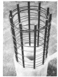
Colonne Gram en béton centrifugé armé
