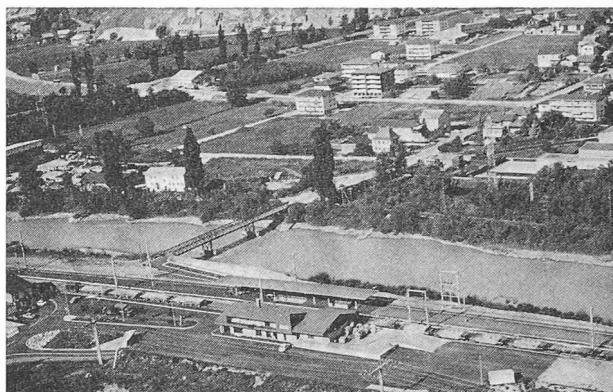
Fig. 171. — Rarogne : la nouvelle station avec son quai intermédiaire et le passage inférieur raccordé à l'ancien pont sur le Rhône.
