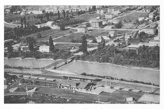
Fig. 171. — Rarogne: la nouvelle station avec son quai intermédiaire et le passage inférieur raccordé à l'ancien pont sur le Rhône.
