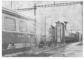
Fig. 164. — Installation de lavage au défilé.
