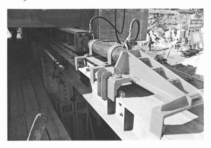
Fig. 191. — Passage inférieur de Malley. Berceau et vérin pousseur pour le ripage de la dalle. Au centre de la photo, deux des butées d'appui du système.
