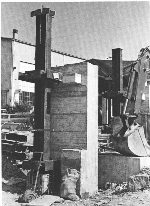
Fig. 189. — Passage inférieur de Malley. Détail du dispositif d'abaissement de la dalle schématisé à la figure 188. En bas à gauche, sous la colonne métallique, on distingue l'empilage des galettes de béton fretté.
