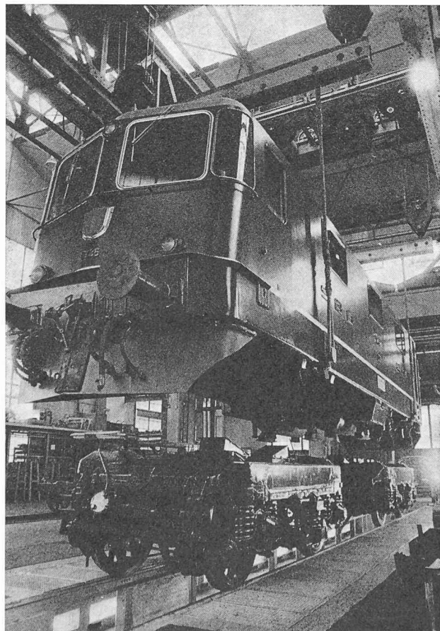
Fig. 128. — Pont-roulant 120 t commandé par radio.
