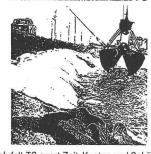
Polyfelt TS spart Zeit, Kosten und Schüttmaterial und hilft besser, billiger und schneller zu bauen. Polyfelt TS – Trenn- und Filterschicht zwischen schlammigem Boden und Kiesdrainage oder Schüttung, im Straßenbau, im Bahnbau, im Wasserbau, bei der Anlage von Sportplätzen, Lagerplätzen oder Grünflächen auf Dachterrassen.
