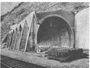
Fig. 101. — La pose des voies au portail de Seefels, du côté Bienne, en 1968. Au premier plan, l'ancienne simple voie à l'air libre encore en service.
