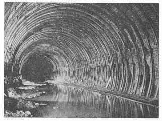
Fig. 99. — Le blindage de la fouille du tunnel, avant le bétonuage de la voûte.
