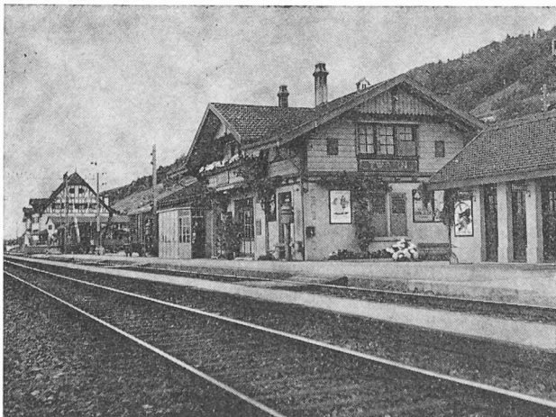
Fig. 107. — L'ancienne gare de Douanne, utilisée jusqu'en 1972. Cet emplacement a été excavé en 1973-1974 pour l'aménagement de la tranchée couverte destinée à la RN 5. Actuellement, on y procède à des fouilles archéologiques.
