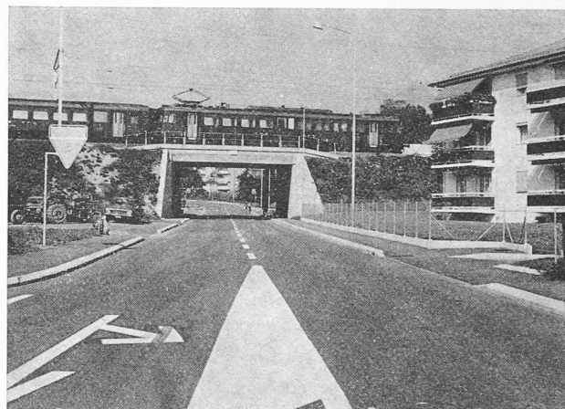
Fig. 90. — Le nouveau passage inférieur de Pinguet, à Saint-Prex, qui remplace, pour le trafic routier, le passage à niveau de la gare, supprimé en 1974.
