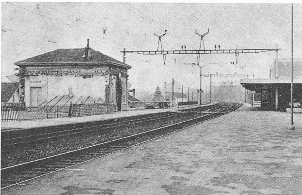
Fig. 87. — Rolle : à droite, le nouveau bâtiment de la station. On distingue, sur le quai de gauche, l'ancien bâtiment en cours de démolition (photo Yves Jault).
