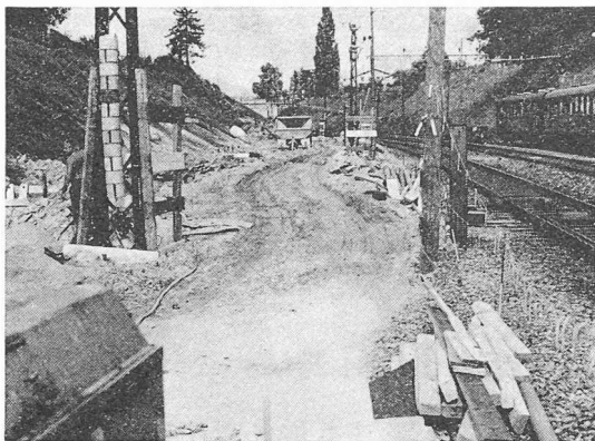
Fig. 91. — Les travaux de terrassement (environ 12 000 m 3 ) à l'entrée est de la gare de Nyon, qui doivent permettre d'augmenter le rayon de courbure de la voie.
