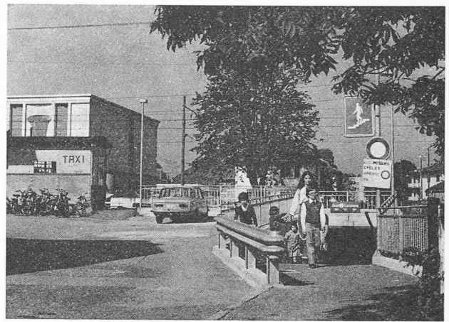
Fig. 89. — A Saint-Prex, les travaux de transformation sont en cours. Le passage à niveau de la gare, qui se situait à cet emplacement, a été supprimé en mars 1974. Il a été remplacé par un passage inférieur pour piétons, aménagé au même endroit, et par un passage inférieur routier, situé 200 m plus à l'est.
