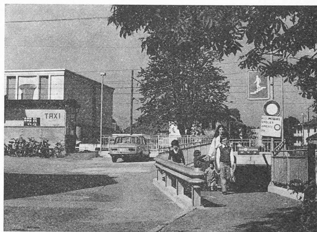
Fig. 89. — A Saint-Prex, les travaux de transformation sont en cours. Le passage à niveau de la gare, qui se situait à cet emplacement, a été supprimé en mars 1974. Il a été remplacé par un passage inférieur pour piétons, aménagé au même endroit, et par un passage inférieur routier, situé 200 m plus à l'est.
