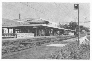
Fig. 88. — La nouvelle gare de Rolle, terminée en 1975. Outre la reconstruction des bâtiments (bâtiment aux voyageurs, halle aux marchandises, abri sur le quai), le programme comportait l'aménagement d'un nouveau passage inférieur, la prolongation des quais, l'installation d'un nouvel enclenchement électrique, et la pose d'une nouvelle diagonale d'échange de voie, côté Genève.
