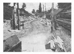
Fig. 91. — Les travaux de terrassement (environ 12 000 m³) à l'entrée est de la gare de Nyon, qui doivent permettre d'augmenter le rayon de courbure de la voie.
