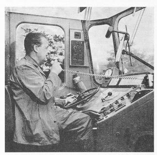
Fig. 80. — Liaison radio entre mécaniciens de locomotive et gares avoisinantes, en service sur la ligne du Saint-Gothard.
