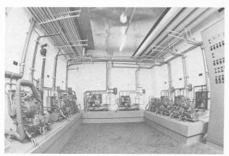
Fig. 15. — Local des compresseurs frigorifiques.
