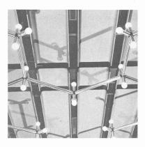
Fig. 12. — Aménagement des grilles de pulsion dans le faux plafond de l'aula sous l'éclairage artistique.
