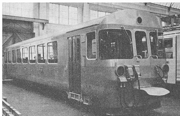
Fig. 8. — Rame destinée aux Chemins de fer fribourgeois (GFM), étroitement apparentée à la précédente, en cours de montage. On remarquera la porte frontale permettant l'accès aux voitures remorquées. (Photo SA des Ateliers de Sécheron.)
