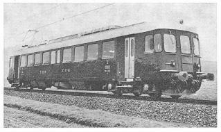
Fig. 5. — Automotrice lourde RBe 4/4 des CFF; il s'agit du type le plus répandu parmi ceux issus de celui de la figure 4. (Photo CFF.)
