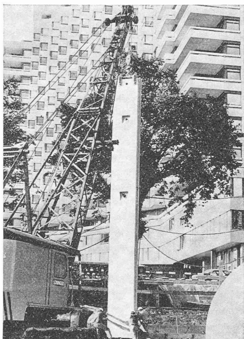
Fig. 10. — Mise en place d'un élément. Dans le fond, l'Hôpital de l'Ile.
