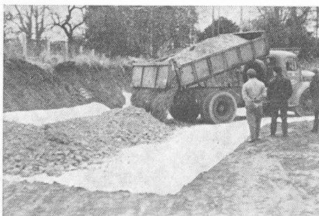
Fig. 9. — Pose d'une nappe non tissée.
