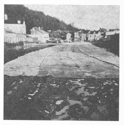
Fig. 11. — Exemple type d'un non-tissé anticontaminant.
