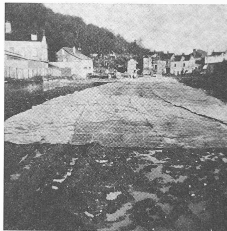
Fig. 11. — Exemple type d'un non-tissé anti-contaminant.
