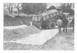
Fig. 9. — Pose d'une nappe non tissée.
