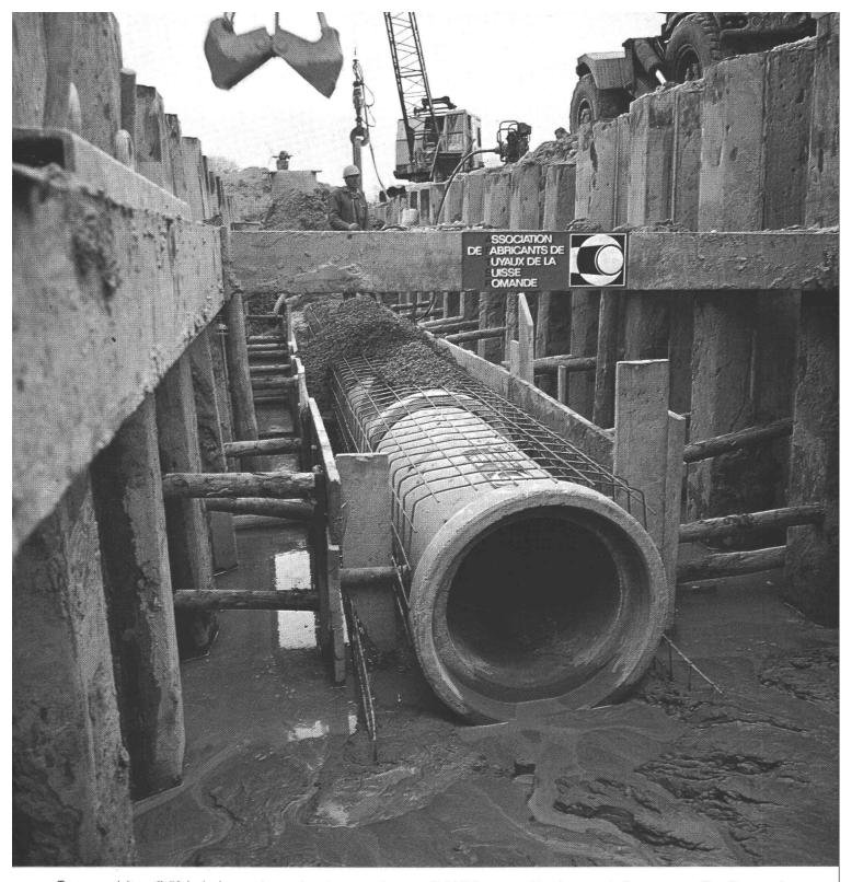
Tuyaux en béton Ø 70 à cloche, posés sur des pieux, enrobage profil IV SIA avec treillis, dans terrain fortement aquifère (limoneux). Bureau d'Ingénieurs : J. M. GRELLET & Cie, NYON. Entreprise : PERRIN Frères S.A., NYON. Chantier : RC 1 sous la Lignière.
