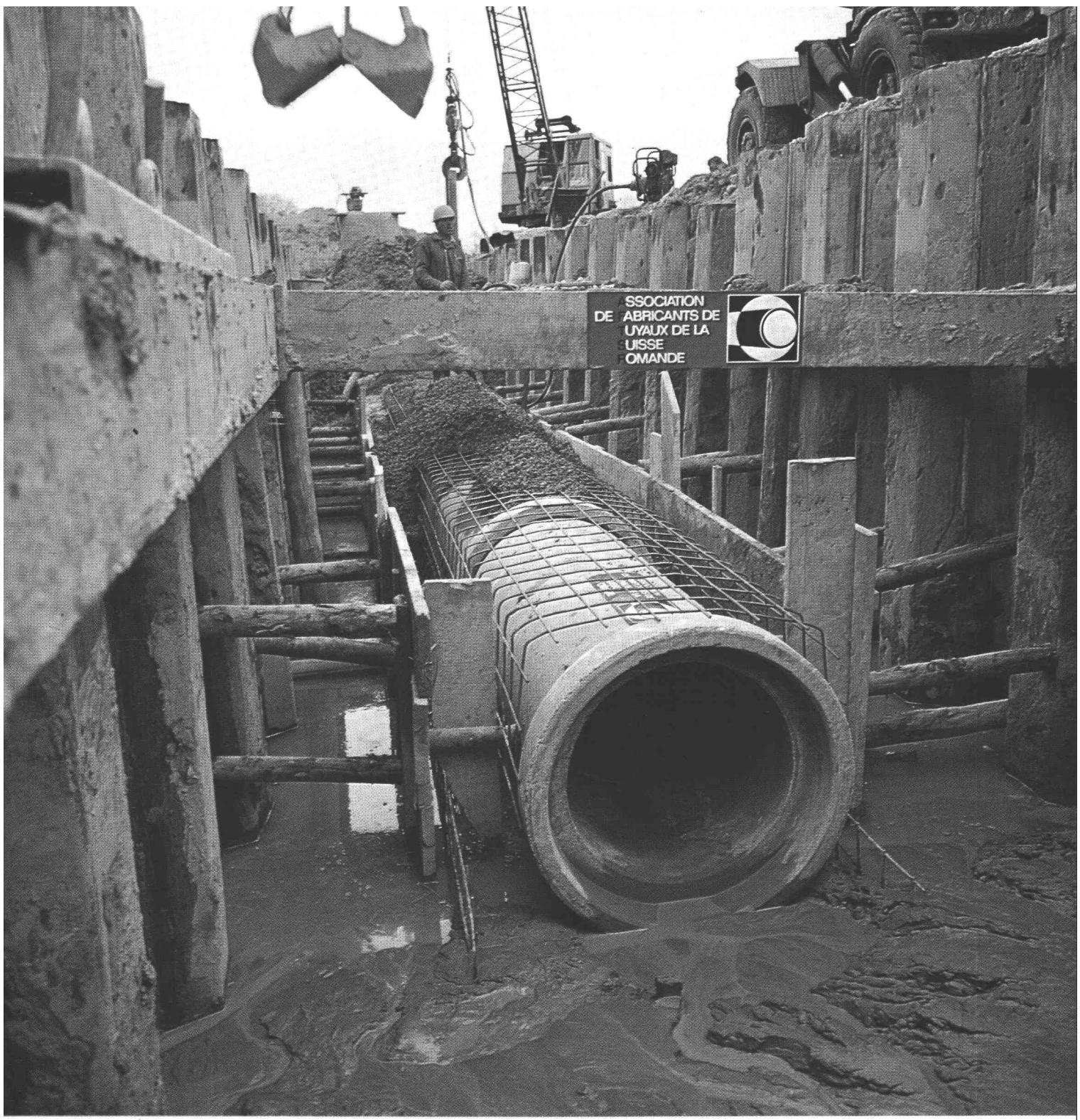
Tuyaux en béton Ø 70 à cloche, posés sur des pieux, enrobage profil IV SIA avec treillis, dans terrain fortement aquifère (limoneux).
