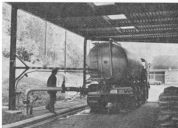
Fig. 19. — Arrivée des boues épaissies à Roche.
