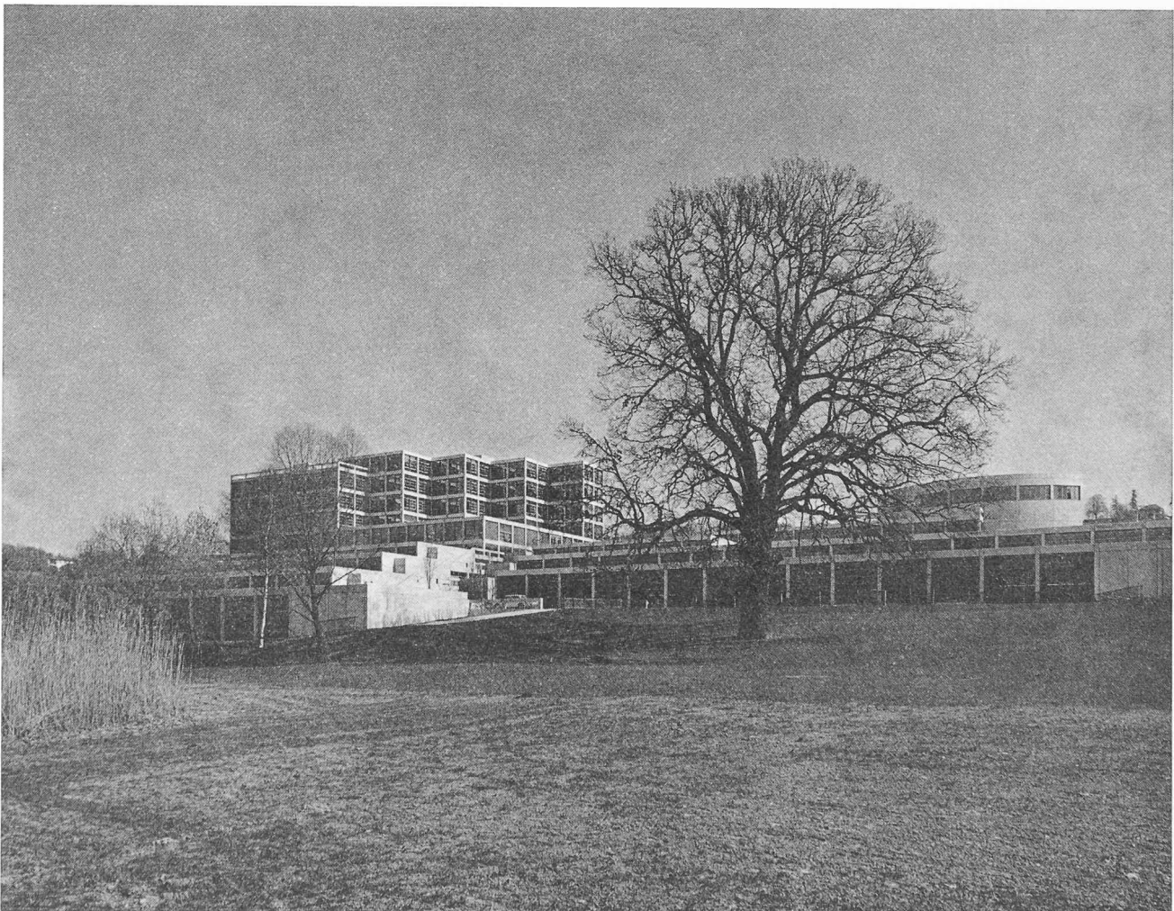
Fig. 1. — L'Ecole technique supérieure vue de l'ouest.
