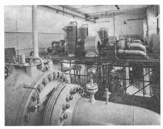
Dans la salle des machines, particulièrement insonorisée, trois turbocompresseurs Sulzer, d'une puissance de 3700 kW chacun, ont un débit total de 910 000 m³/h.
