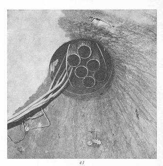
Fig. 30. — Tubes de guidage des câbles de l'électricité dans les forages (photos Direction d'arrondissement des téléphones, Genève).
