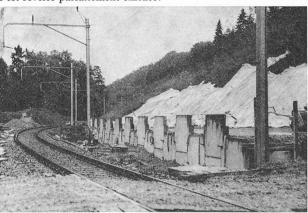
Cette couche de fond achevée, le remblayage pouvait se faire sur toute la surface. Travaillant toujours sur la plate-forme formée par la dernière couche remblayée, l'équipe pouvait se déplacer en toute sécurité, protégée contre les risques de chute ou contre les risques d'accident avec le train par la demi-écaille (75 cm) qui n'était pas encore remblayée.
