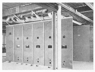
Fig. 18. — Panneaux en aggloméré avant le montage des installations sanitaires.
