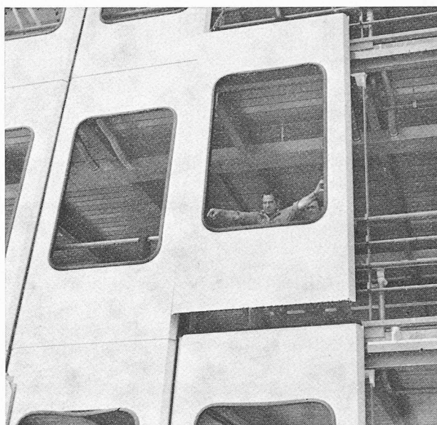
Fig. 10. — Montage d'un panneau de façade.
