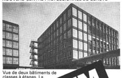
Vue de deux bâtiments de classes à étages. La structure est stabilisée par un noyau central en béton. Les planchers sont métalliques.
