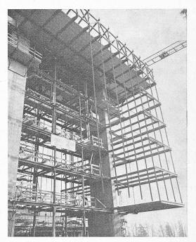
Fig. 7. — Front est: montage du plancher inférieur (avril 1972).
