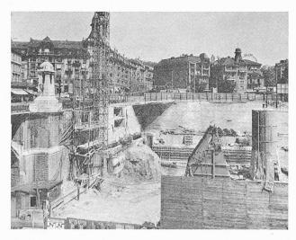
Fig. 2. — Bétonnage de la partie inférieure des murs de soutènement (23 août 1971).
