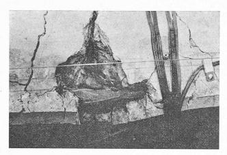
Fig. 19. — Rupture de l'armature passive.
