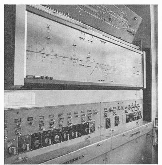
remplacer cet appareil et transformer le système d'autorisation à leviers mécaniques par un appareillage électrique ne comprenant que des touches et des voyants lumineux.
