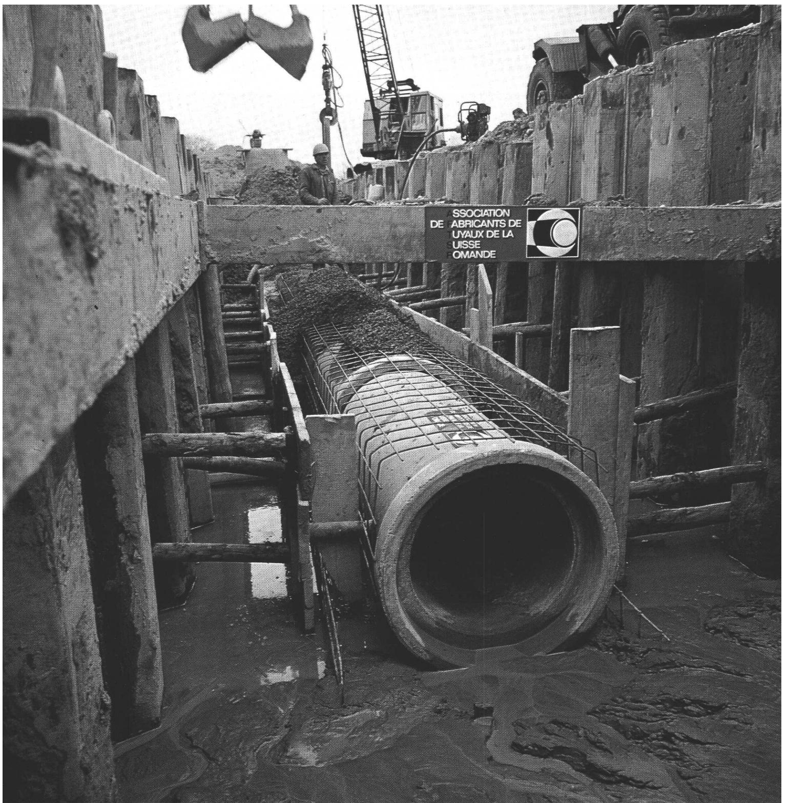
Tuyaux en béton Ø 70 à cloche, posés sur des pieux, enrobage profil IV SIA avec treillis, dans terrain fortement aquifère (limoneux).
