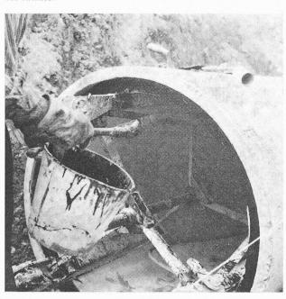
Le jointement souple est réalisé impeccablement à l'aide d'une matière étanche plastique. Un matériel est plastique s'il se déforme sous une contrainte et reste déformé après la disparition de celle-ci.
