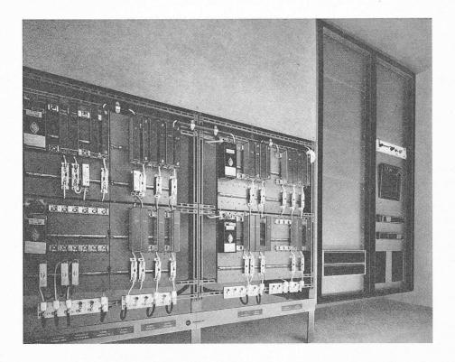
Fig. 3. — Station de tête équipée de tous les éléments nécessaires au conditionnement des signaux.
