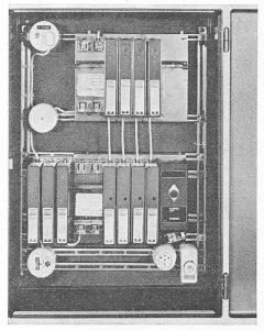
Fig. 9. — Amplificateur tertiaire (d'immeubles) avec reconversion des programmes S en UHF.
