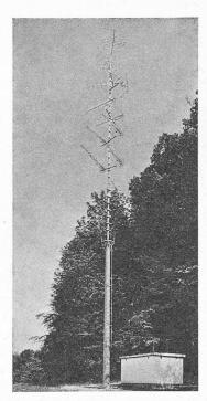
Fig. 1. — Pylône de dégagement avec nacelle, supportant un mât et des antennes pour la réception des OUC et TV.
