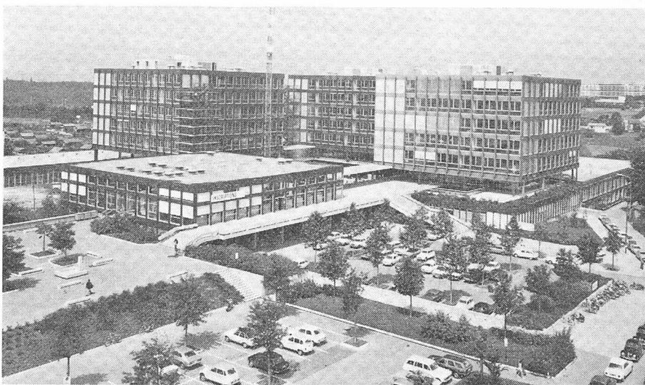
Fig. 1. — Vue d'ensemble du Centre professionnel. Etat actuel des travaux.
