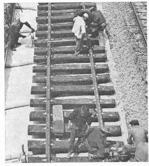
Fig. 2. — Pose de la voie sur une nappe synthétique non tissée «  $\operatorname{Bidim} > 1$ .
