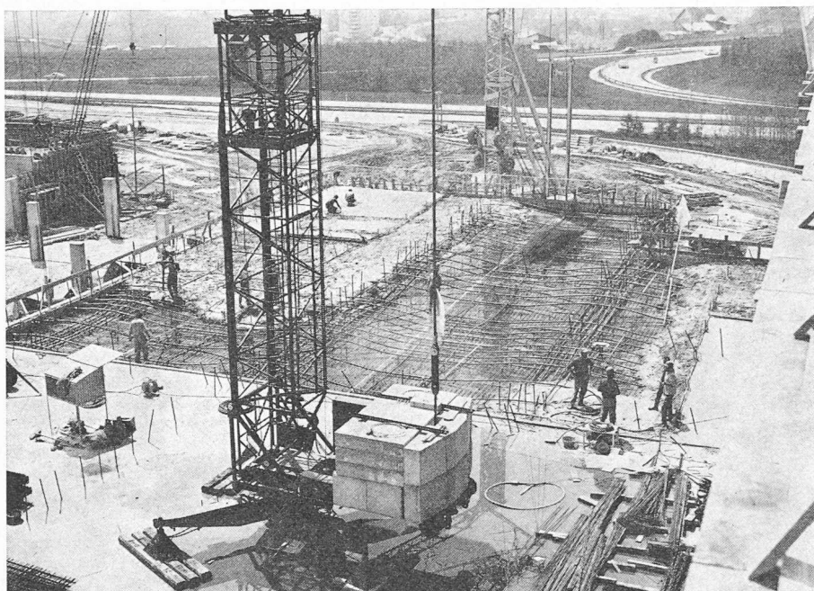
Fig. 6. — Vue générale pendant le bétonnage d'une étape de dalle sur le garage police.
