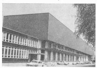
Fig. 2. — Façade en Colour Galbestos: bâtiment industriel à Genève (Bois et matériaux de construction SA. Architectes: Hermès et C<sup>1e</sup>, Genève).
