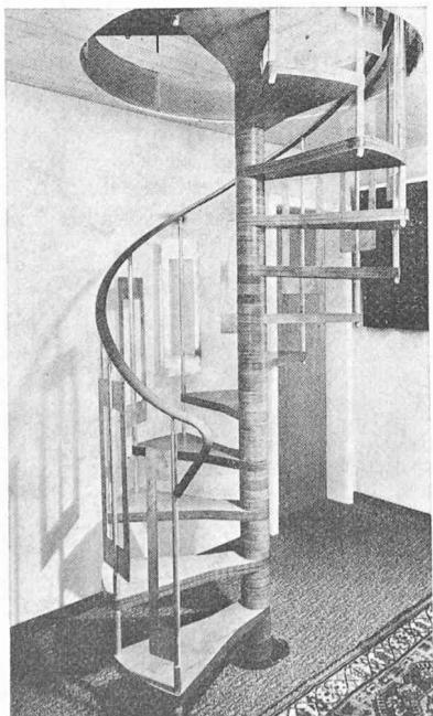
la solidité de l'ensemble. Le développement des marches, le départ, l'arrivée, tout est fixé aisément grâce à des systèmes précis de réglage. La hauteur des marches est obtenue tout aussi aisément par des cales d'espacement.
