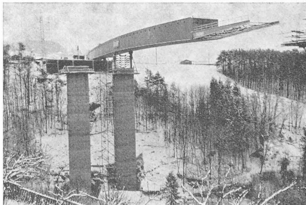
Fig. 7. — Lancement d'une poutre maîtresse. De nouvelles méthodes de montage réduisent les frais et augmentent la sécurité.
