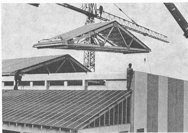
Eléments de parois fonctionnels et éléments préfabriqués de toiture en bois et dérivés du bois.
